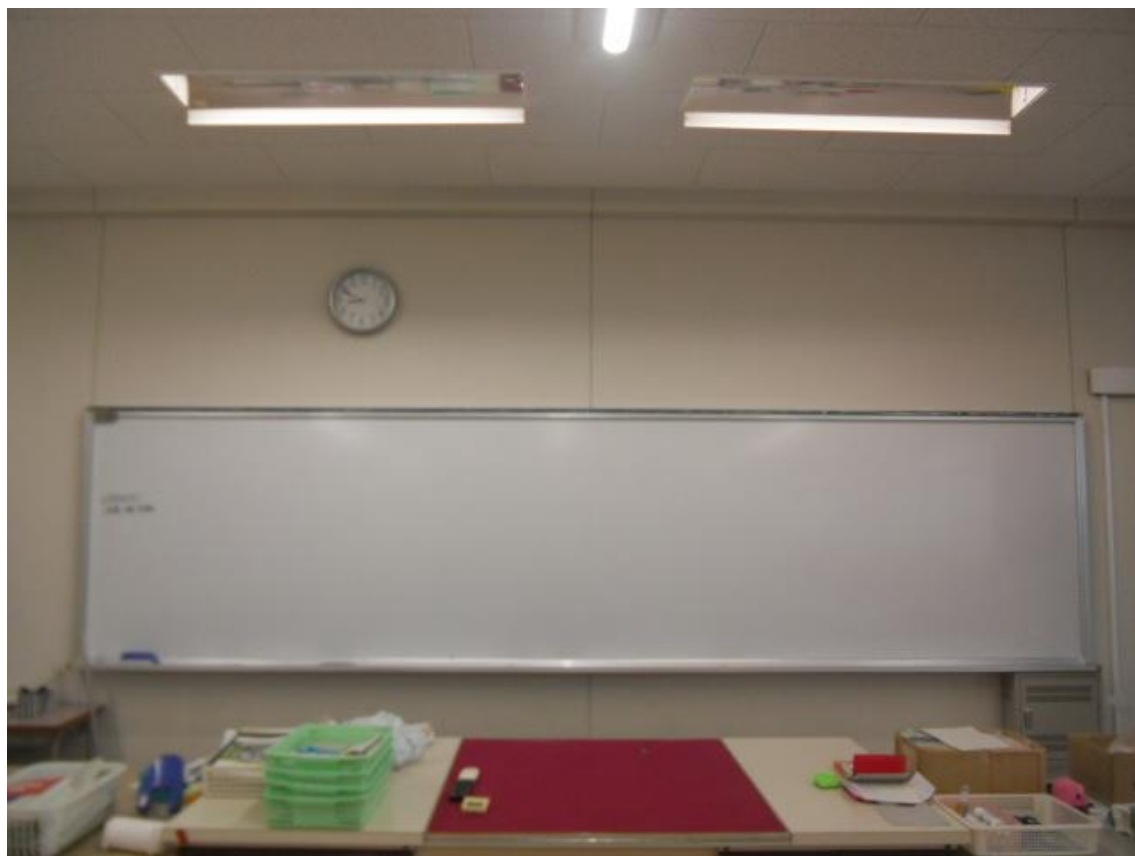
総合学科棟 2階被服総合実習室
